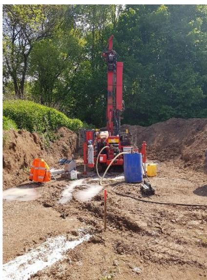
Dans le cadre du projet de création de la nouvelle station d'épuration, des forages ont été réalisés à la fin du mois d'avril dernier. Ces forages, situés près de la station d'épuration actuelle et au niveau d'un nouveau poste de refoulement, ont pu aller jusqu'à 15 mètres de profondeur. Ils ont pour but la réalisation d'une étude géotechnique du sol.
