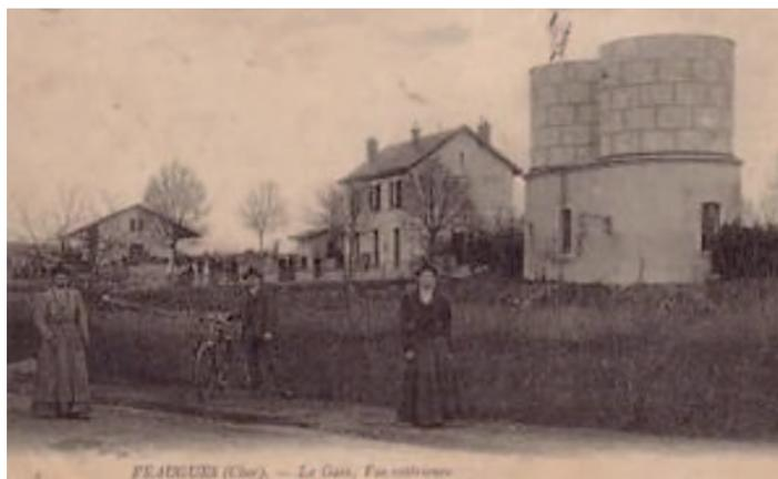
Gare de Veaugues en 1907. Les réservoirs permettaient de stocker l'eau nécessaire aux locomotives à vapeur.
